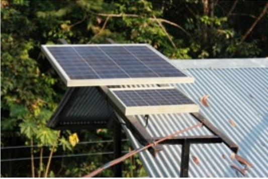
Panneaux solaires pour charger les batteries
